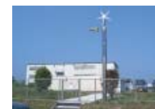
ソーラー + 風力発電の仕様 シリコン太陽電池:96W 風力発電:50W
