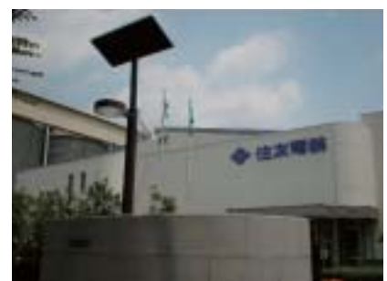
狭山サイトに設置したソーラーパネルと照明施設
