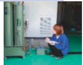
コンプレッサードレンの点検作業
