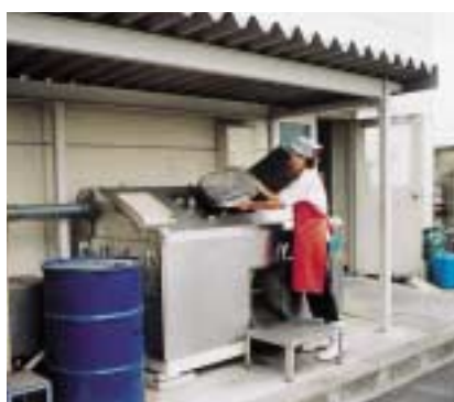
食堂外に設置されたバイオリサイターで残飯などを堆肥化し廃棄物をゼロに削減
