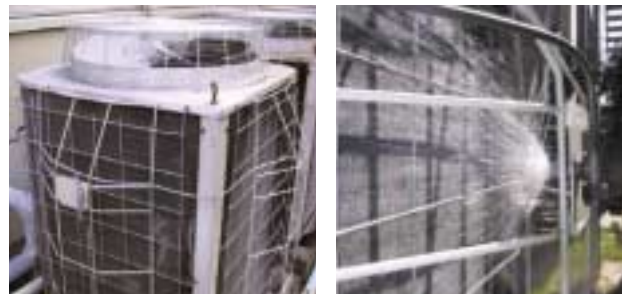
室外機に水を噴霧しその気化熱を利用して熱交換率をUP
