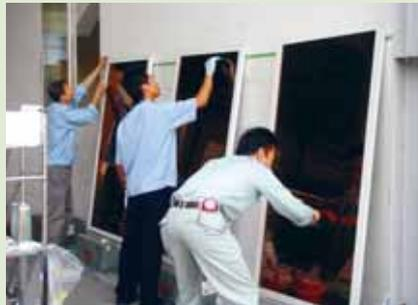
援も受けましたが、施工そのものはSHWS社の生産技術部員が担当しています。第2、第3工場を中心に当社にある全ガラスの4割に対して施工し、その効果を検証したところ、昨年度と同じ外気温であった月において、工場内の温度は対前年比で1.5℃~1.7℃の低減効果が認められました。電気代の節約コストは、約14万円/月にもなっています。遮熱ガラスコーティング施工投資総額は37万円程度だったので、投資回収月数は約3ヶ月ほどであり、経済面でもメリットの大きな取り組みでした。残りの6割のガラスについても
