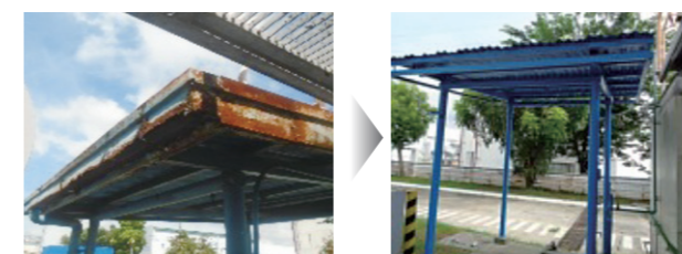
修繕前(写真左)と修繕後(写真右)の建屋
